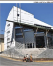
El edificio de la Fiscalía de Santiago, que se está construyendo en Providencia.
